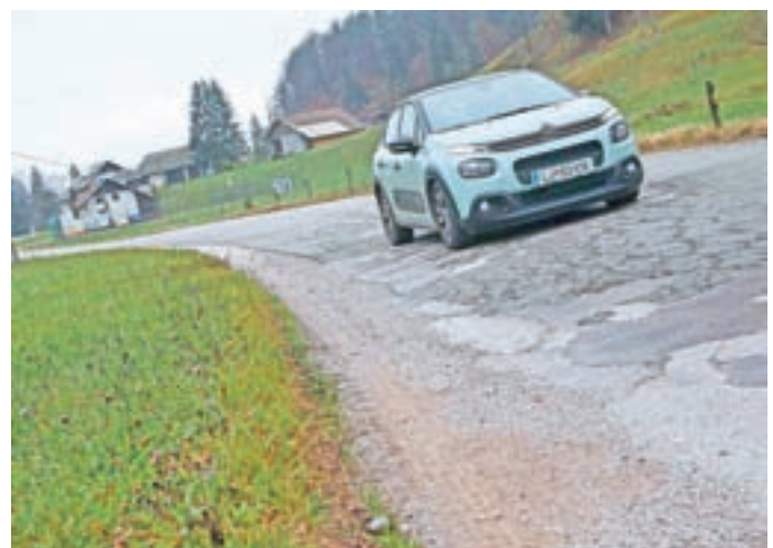
Cesta v Račevo je bila dodatno poškodovana, ko so po njej speljali obvoz ob obnovi državne ceste proti Logatcu. / Foto: Gorazd Kavčič
